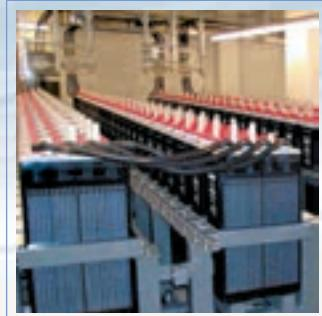
Рис. 17 Смонтированная батарея Classic OCSM
