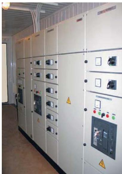
РУ-0,4 кВ выполнено на базе НКУ Щ0-2000 «Нева», которое состоит из модульных элементов и позволяет создавать щиты любой конфигурации в стационарном или выдвижном исполнении с различными вариантами разделения функциональных узлов.
