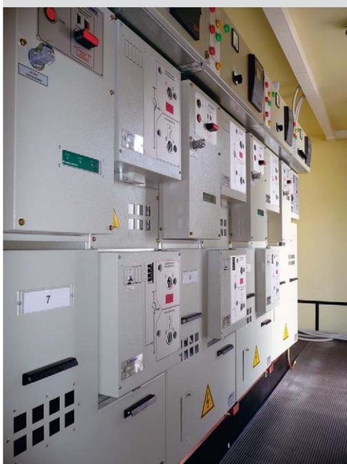
Распределительное устройство на базе ячеек КСО «Онега» в БКРПБ
