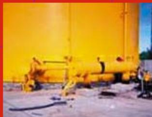
Циркуляционный нагреватель 500кВт взрывозащищенный
