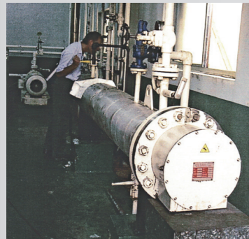
Перегреватель воды с 30 % ДТ - 110 кВт 480 В - 15 бар - Темп. 110° С
