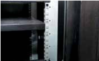
На монтажные профили нанесены метки, обозначающие высоту каждого юнита
