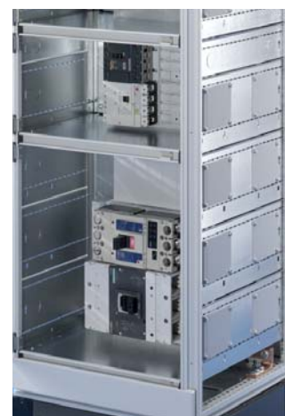
Прокладка шинной системы внутри секции (Indoor)
