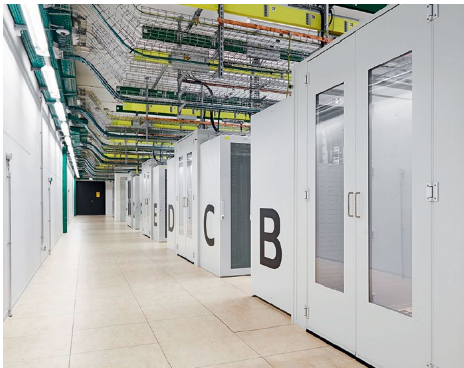
После создания всех четырех модулей в ЦОД было размещено 600 стоек. Примерно на 25 000 ЕВ было размещено около 6000 серверов и сетевых компонентов.
