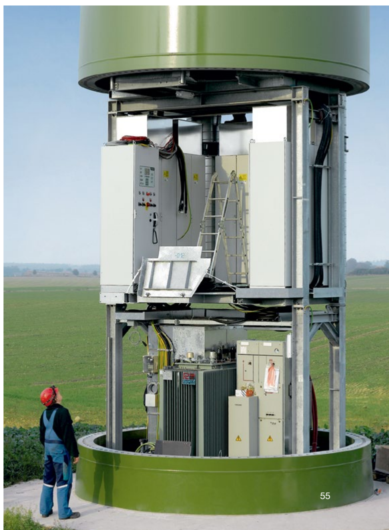
Компания Enercon размещает преобразователи частоты для ветряных турбин в шкафах TS 8 компании Rittal.
