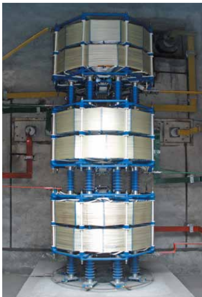
На объекте ОАО «Мариупольский Металлургический Комбинат им. Ильича» (Украина)
