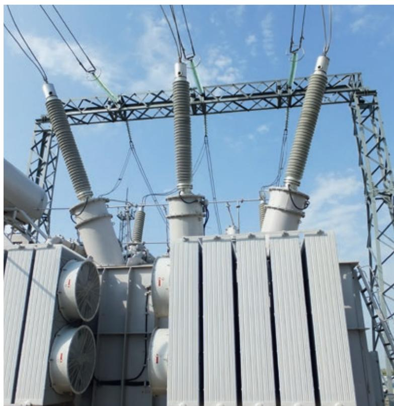
*Вводы 330 кВ компании «Изолятор» на трансформаторе магистральных электрических сетей*
