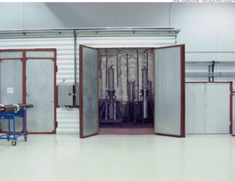
Рис. 16. Тепловое отверждение полимерной изоляции на заводе «Изолятор»
