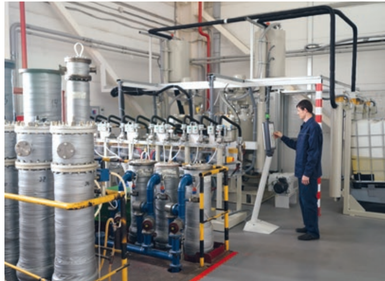
Рис. 13. Машина Hubers для вакуумной пропитки изоляции на заводе «Изолятор»
