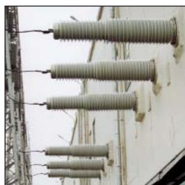
■ элегазовые вводы на класс напряжения 220 кВ для комплектации КРУЭ
