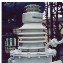
■ съемные вводы на напряжение от 20 до 35 кВ для силовых трансформаторов
