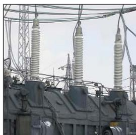
■ вводы на классы напряжения от 35 до 1150 кВ для силовых трансформаторов и реакторов
