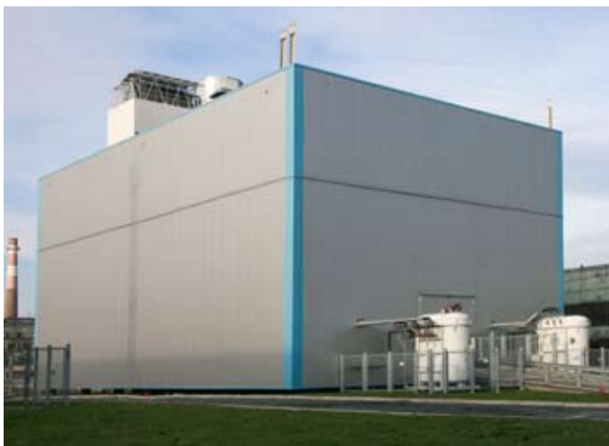
Газотурбинная теплоэлектростанция (ГТ ТЭЦ) на территории ЗАО «Энергомаш (Екатеринбург) – Уралэлектротяжмаш»
