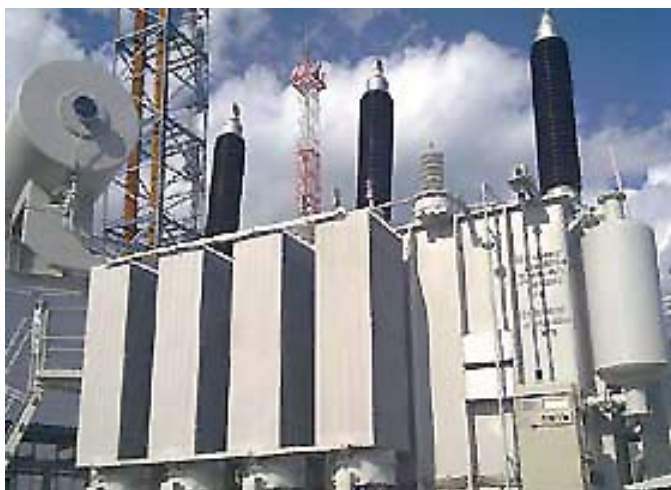
Трансформатор ТДН-25000/220ВМ УХЛ1 в сейсмостойком исполнении
