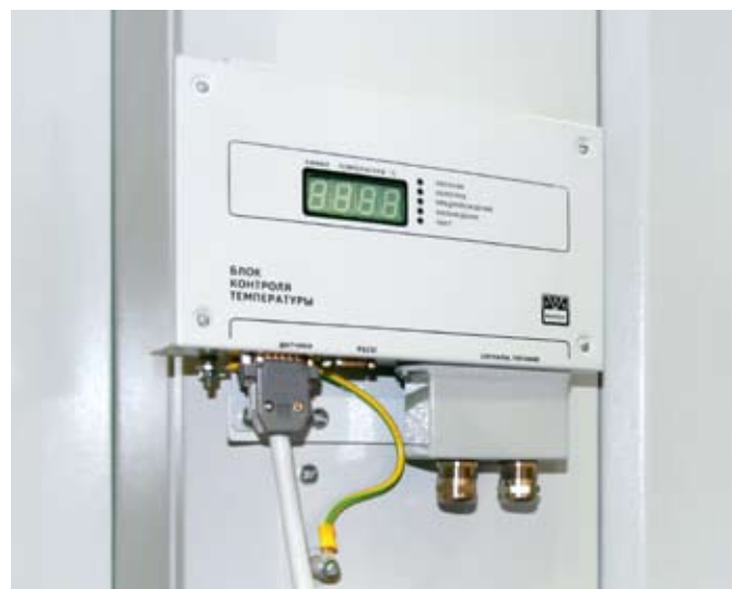
Блок контроля температуры
