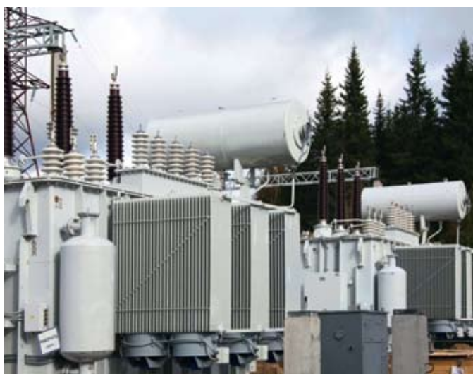
Монтаж трансформаторов ТДТН-16000/110 VI на ПС «Ляскеля», о. Валаам, Республика Карелия, 2009
