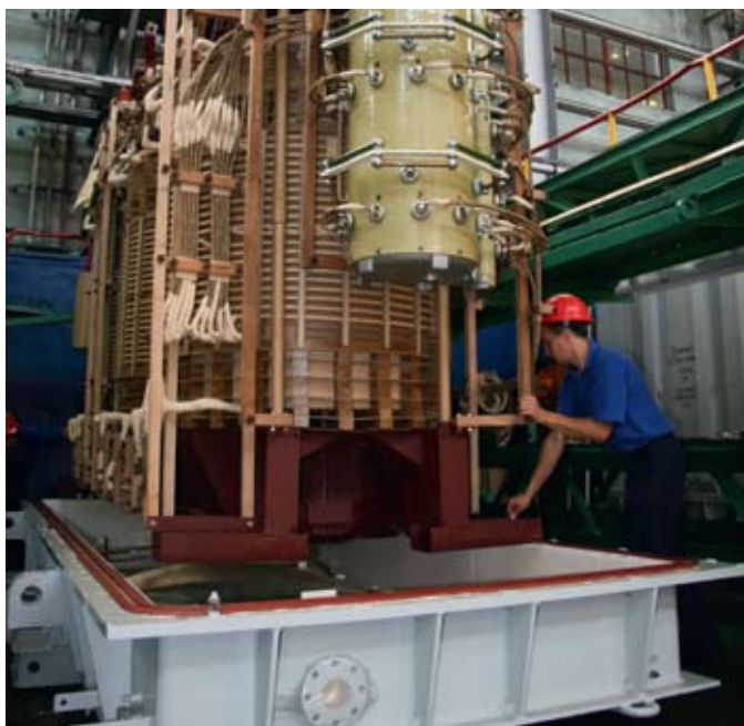
Установка активной части трансформатора в бак
