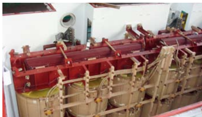
Установка активных частей трансформатора ТАДЦНПФ-40000/10 УХЛ1 в бак
