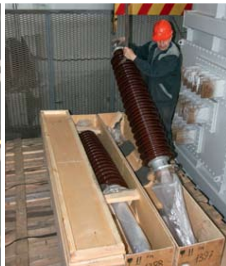
Вводы BRIT-R производства «ABB» (Швеция-Россия) с RIP изоляцией
