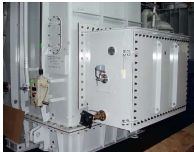
Приставное переключающее устройство производства «ABB»
