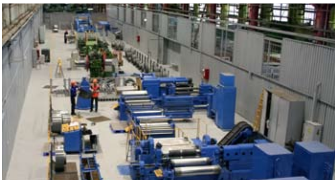
Линия резки электротехнической стали фирмы «GEORG»
