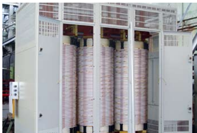
Трансформатор ТСЗП-2500/20 ВМ УЗ
