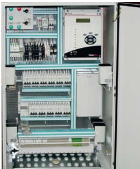
Шкаф управления, защиты и сигнализации
