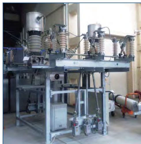
БЛОК ВЫСОКОЙ ГОТОВНОСТИ БВГ-35
