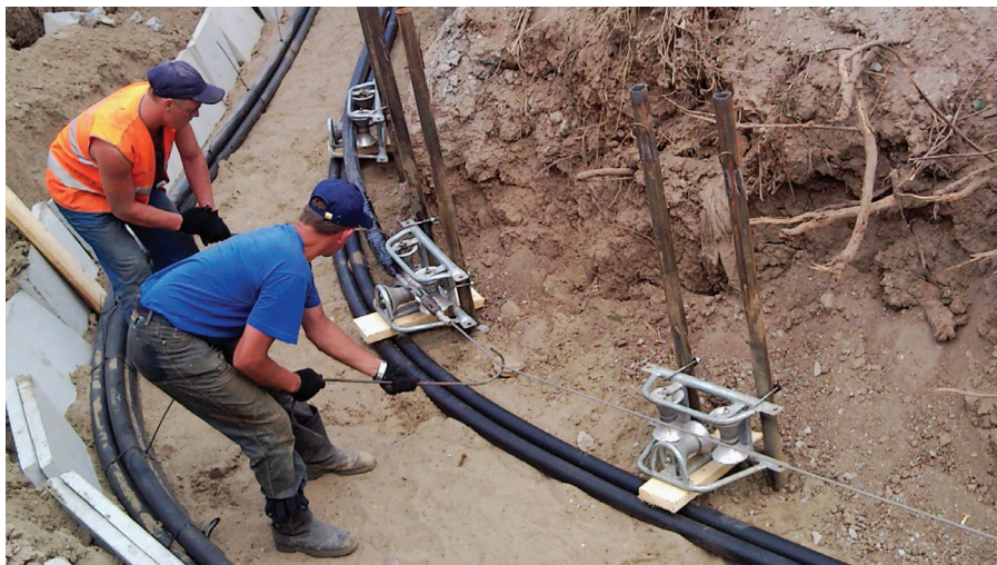
Рисунок 19. Процесс прокладки кабеля. Оттяжка крюками в повороте
