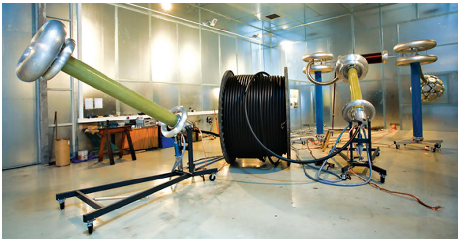
Испытательная станция HIGH VOLT
