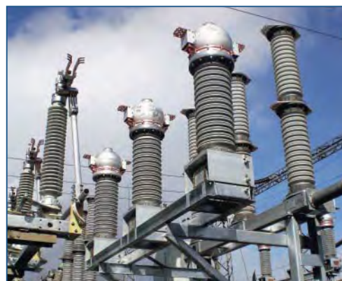
Совместная установка ВГТ-110 и ТРГ-110
