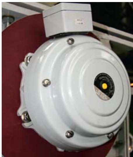
Предохранительный клапан фирмы «Qualitrol» (США)
