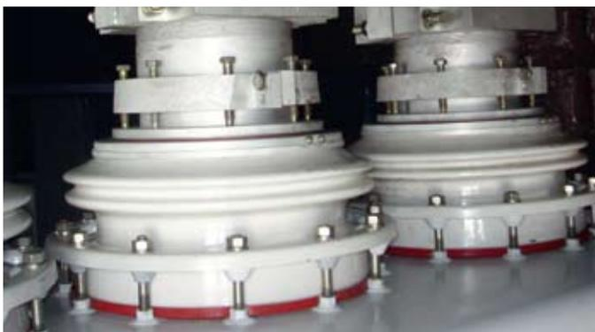
Вводы вентиляльной обмотки преобразовательного трансформатора
