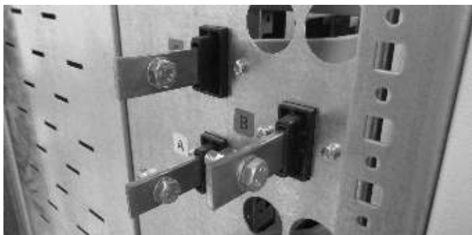
◀ Пример установки изолятора ИНП
