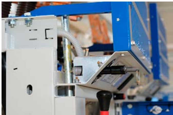
Электромагнитная блокировка
