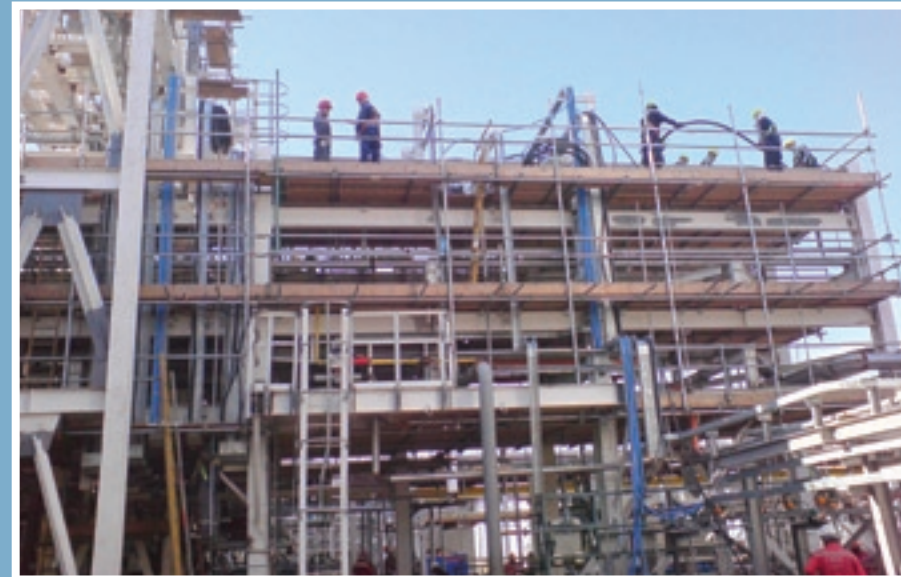
УПГ на месторождении Чинарёво. Прокладка кабеля Installation of preparation of gas on field Chinarevo. Cable laying
