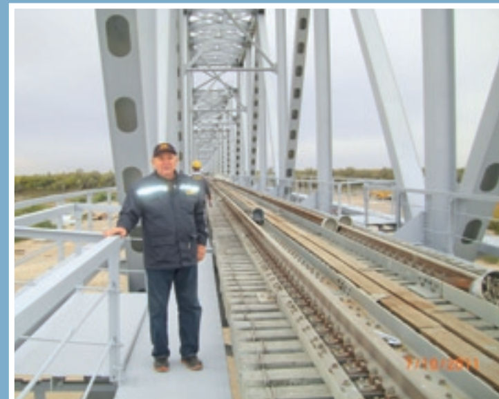
Строительство железнодорожной линии «Жетыген-Хоргос». ВЛ-10кВ переход через мост р. Или Construction of Railroad Lines «Zhetysgen-Korgas». HVL 10kV
