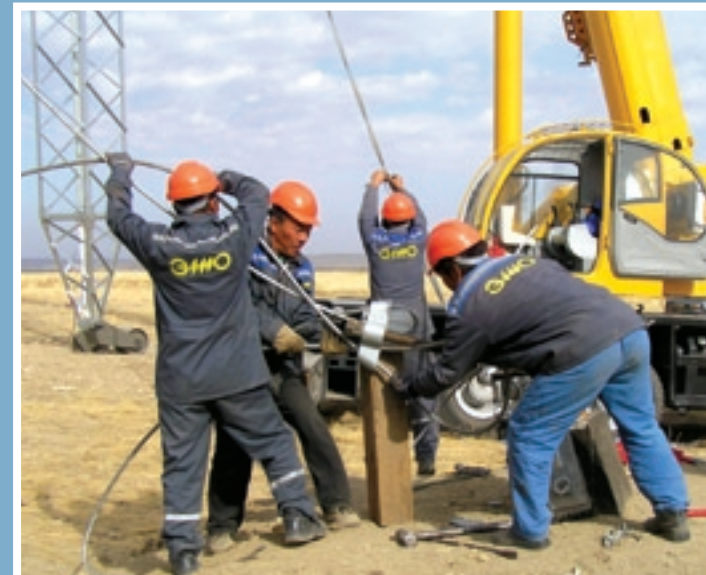
Строительство ВЛ-500кВ Construction of HVL 500kV
