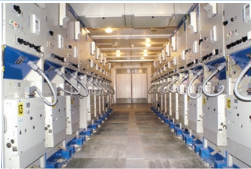
Месторождение «Кумколь». Монтаж закрытого распределительного устройства Field «Kumkol». Installation of Switchgear
