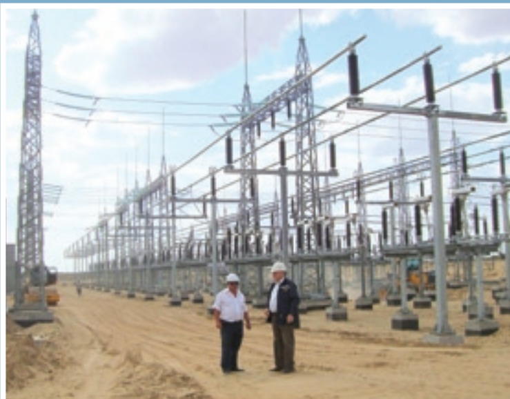
Строительство ГТС «Акшабулак», ОРУ 110кВ Construction of 110kV Switchyard (GTPS «Akshabulak»)
