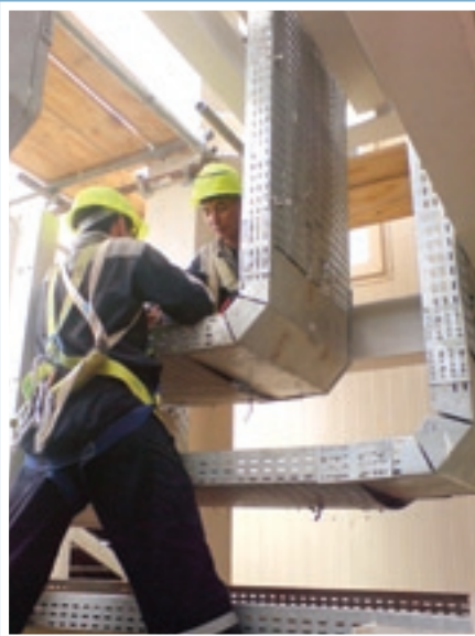
Монтаж кабельных лотков Installation of Cable tray
