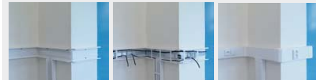
Установка кабель-каналов Элегант ЕКЕ.
