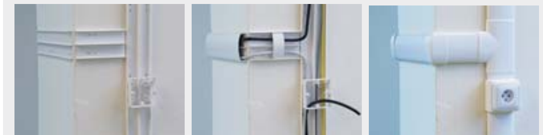
Установка кабель-каналов Элегант LE.
