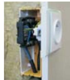
Примеры установки коробок в пустотелые стены
