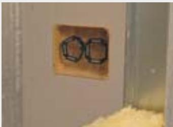
Установка коробки с помощью монтажного кольца
