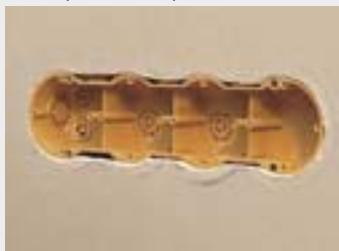
2. Монтаж приборов с межосевым расстоянием 71 мм (горизонтальная рамка).
