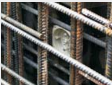
Крышка KBV, прикрепленная на опалубке.
