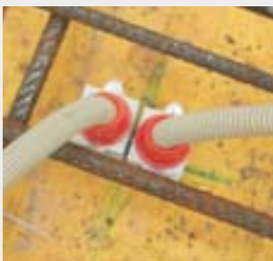
Пример использования концевых втулок и муфт.
