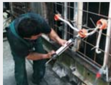
Герметизация вводов (отверстий).
