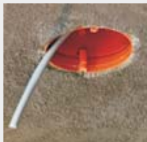
Коробка KBT... с выведенным проводом, готова для установки люстрового крюка KBP...
