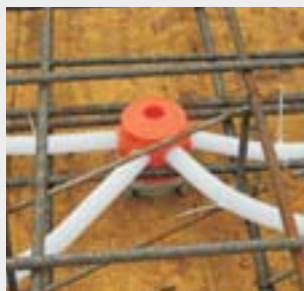
Пример установки в горизонтальной опалубке.
