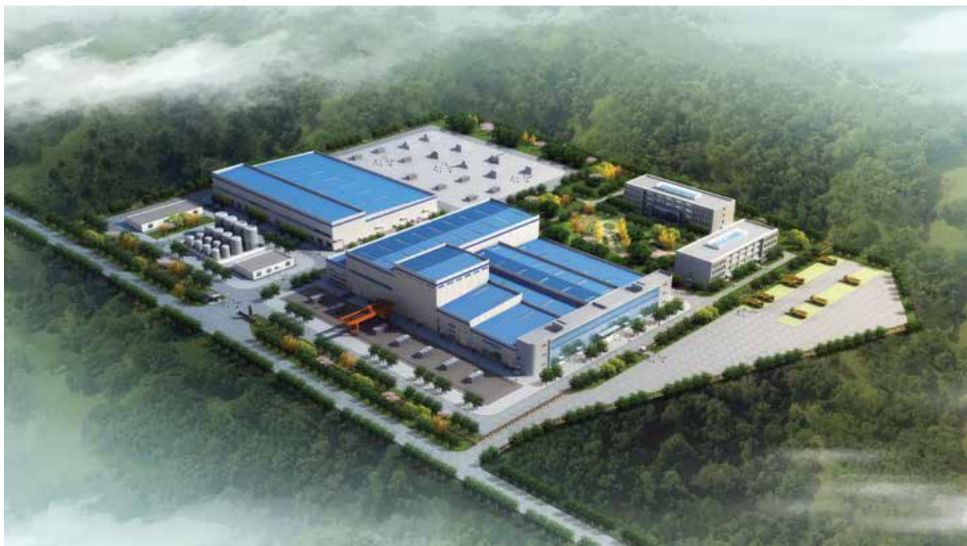
Вид на будущий завод с высоты птичьего полёта.
