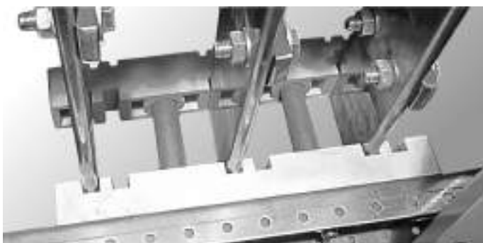
◀ Пример установки шинодержателя ШНП
