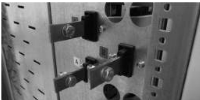
◀ Пример установки изолятора ИНП
