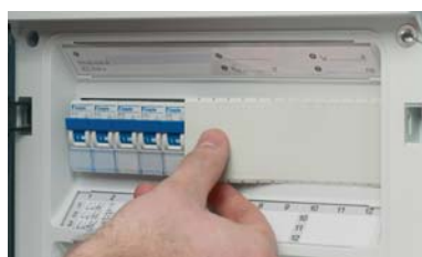
Заглушки неиспользуемых мест входят в комплект поставки
