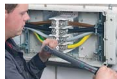
Клеммы должны быть затянуты с определенным усилием
