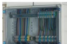
Клеммы для вводных/отходящих кабелей
