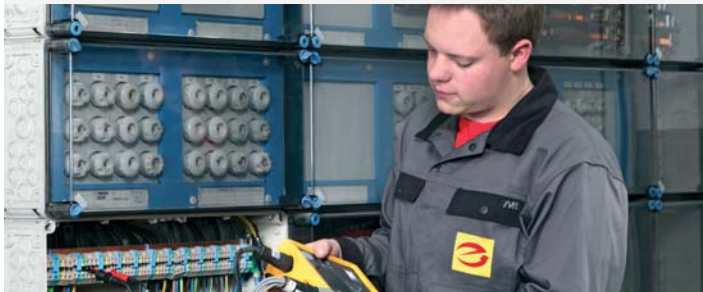
НКУ Mi распределения и управления на токи до 630 А, в соответствии со стандартом ГОСТ Р МЭК 61439 Часть 2
