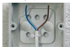
Фиксаторы кабеля DK ZE 10 для установки в основание коробки
