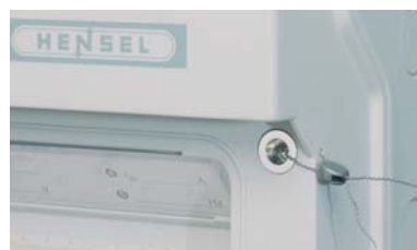
Пломбирование верхней и нижней части боксов KV
