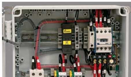
DIN-рейки для установки оборудования или клемм с креплением-защелками
