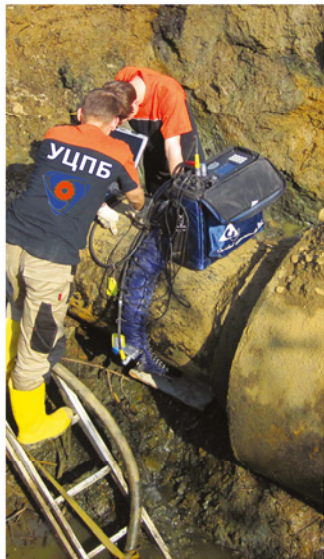
Рис. 6 Контроль участка газопровода, проходящего под дорогой
