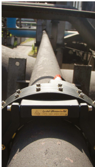
Рис. 7 Участок паропровода длиной 80 м на высоте 5 м
