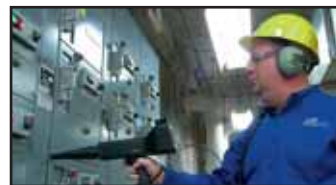
Обследование закрытых шкафов с электрооборудованием
