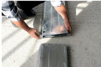
Закрепите соединительный элемент на конце кабельного канала.
