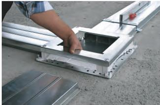
Выгните металлическую пластину для стыковки кабельного канала.
