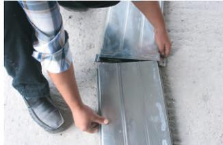
Подсоедините другой кабельный канал к соединительному элементу.
