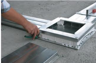
Обрежьте защитную металлическую кромку с учетом ширины кабельного канала.
