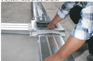
Подсоедините кабельный канал к входному отверстию монтажной коробки.
