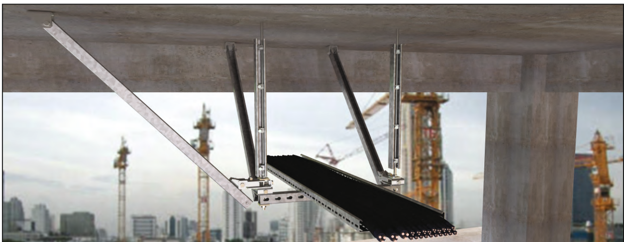
Рисунок 3.7, 3.8, 3.9, 3.10 Жесткое кабельное крепление (стальной стойкой) Применение на кабель-каналах и трубах (изображения из веб страницы Агентства чрезвычайных ситуаций www.fema.gov )
