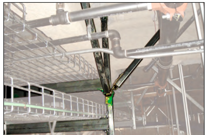
Рисунок 3.7, 3.8, 3.9, 3.10 Жесткое кабельное крепление (стальной стойкой) Применение на кабель-каналах и трубах (изображения из веб страницы Агентства чрезвычайных ситуаций www.fema.gov )
