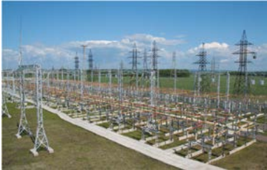
КТП-СЭЩ-Б(М) 220/110/35 кВ
