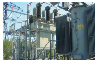
Реконструкция подстанций СТ-7 35/6 кВ
