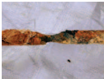
Штырь заземления с цинковым покрытием толщиной 99 мкм, извлеченный из грунта (суглинок) после 10 лет
