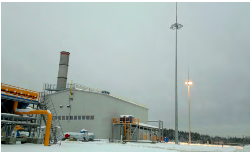
Компрессорная станция «Бабаевская». Газопровод «Северный поток»
