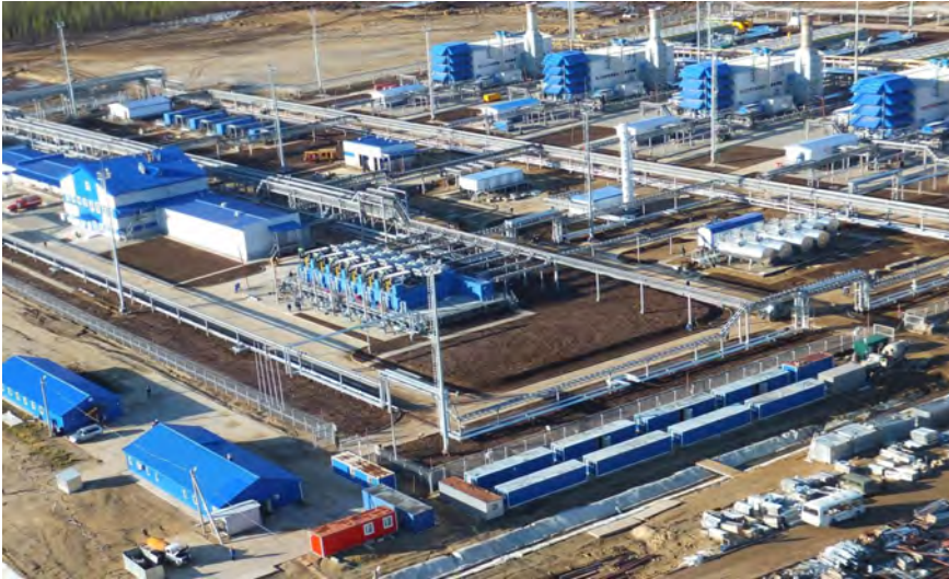
Компрессорная станция «Байдарцкая». Газопровод «Северный поток»
