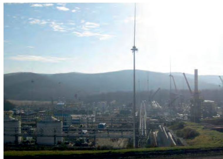
Компрессорная станция «Краснодарская». «Голубой поток», газопровод Россия - Турция на участке Изобильное-Джубга
