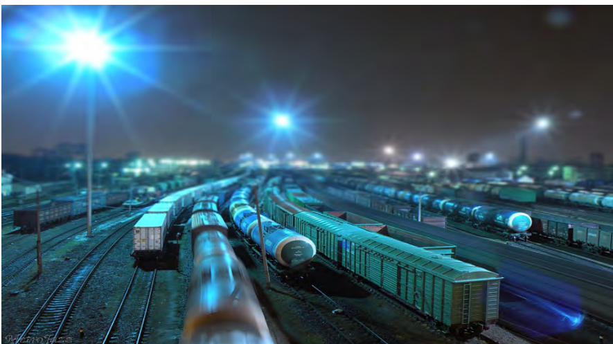
Освещение сортировочных станций с помощью прожекторов на мачтах
