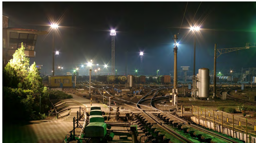
Освещение путей с помощью прожекторов на мачтах
