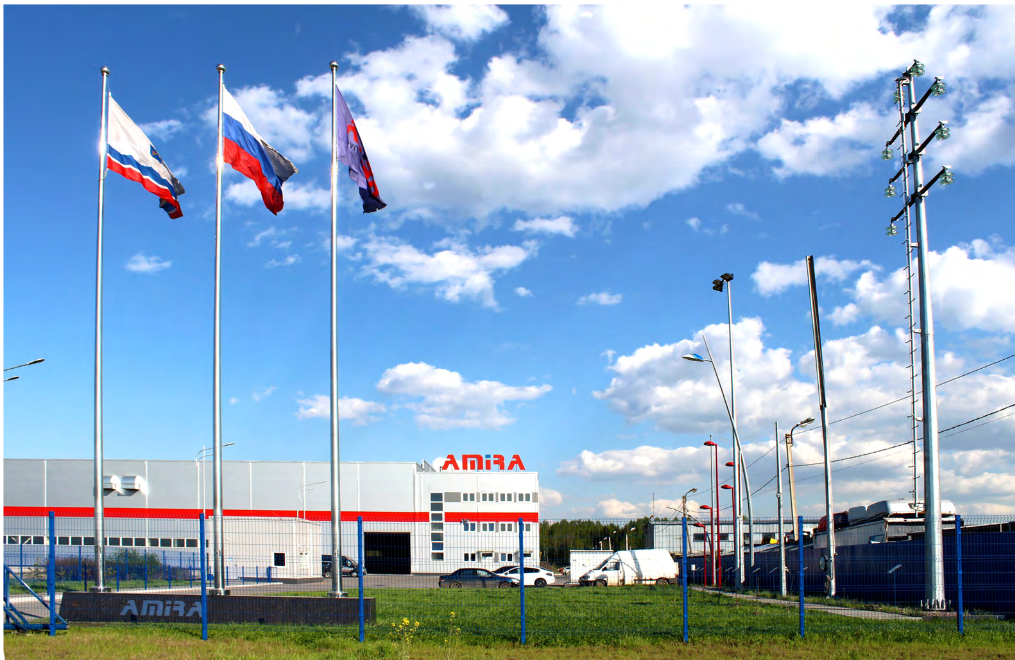
Завод металлоконструкций «Мегаполис». Ленинградская область.
