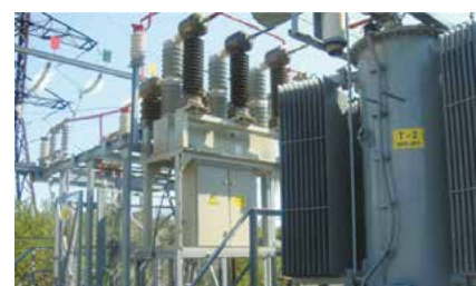
Реконструкция подстанций ST-7 35/6 кВ
