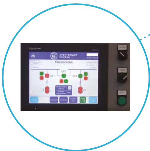
Интерактивная панель оператора реализует человеко-машинный интерфейс
