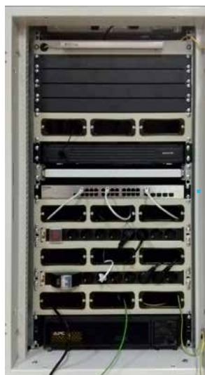
Вариант реализации шкафа системы видеонаблюдения
