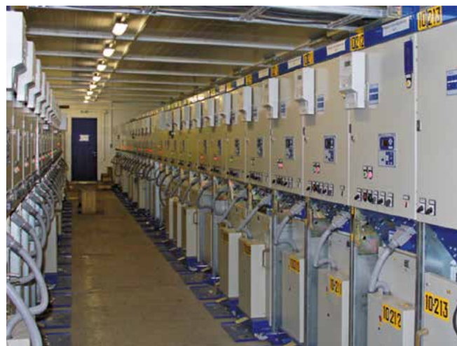
КРУ в блок-модуле
