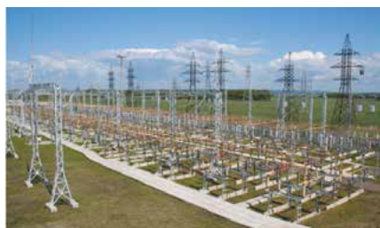
КТП СЭЩ Б(М) 220/110/35 кВ
