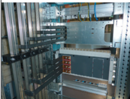
Комплект для подсоединения передающих шин поставляется в разобранном виде
