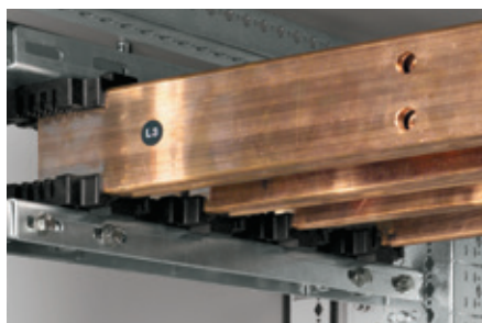
Отрегулируйте глубину установки шины, чтобы соединить ее с другими шинами (момент затяжки 20 Н·м)
