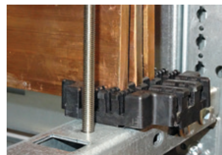
Для предотвращения контакта между шиной и боковой панелью торец шины не должен выходить за середину последнего изолятора.
