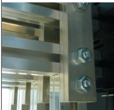
Соединение между алюминиевыми вертикальными и горизонтальными двойными главными шинами, созданное с помощью алюминиевых шин.
