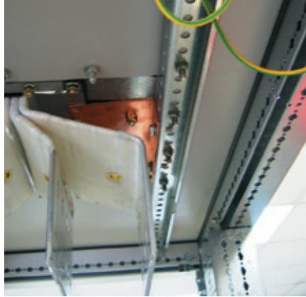
Элемент подачи питания: крепление с траверсами с усилителем верхней панели.
