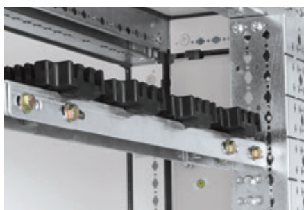
Закрепите суппорты на траверсах 4 клипсами M6 (момент затяжки 10 Н·м)
