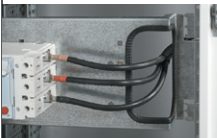
В пластинах имеются вырезы, сквозь которые пропускают кабели. Для защиты этих кабелей на края выреза надевают уплотнитель Кат. № 0 202 40 длиной 20 см.
