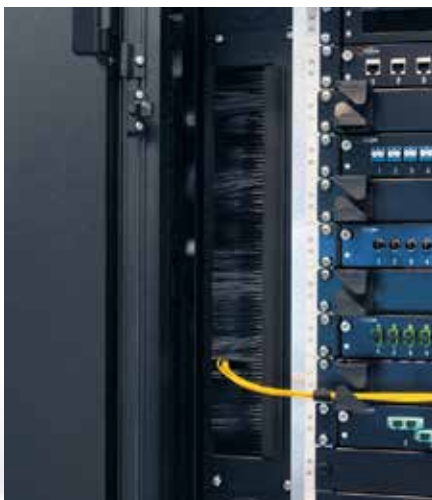
Щеточное уплотнение кабельного ввода
