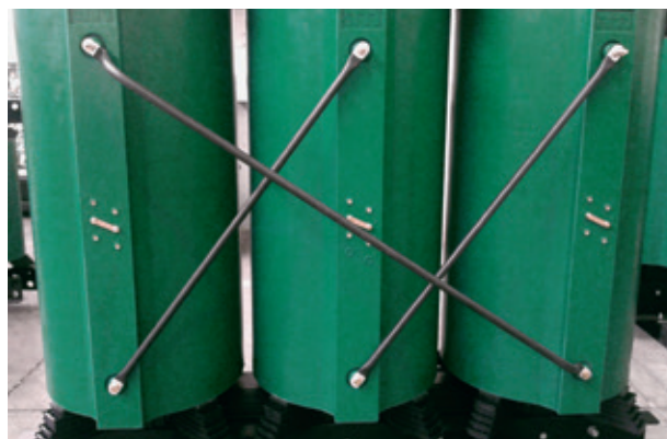
Пример выполнения выводов обмотки высокого напряжения
