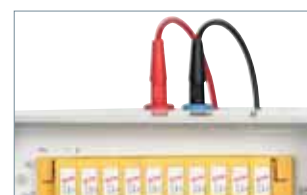
Прямое подключение к тестовому адаптеру для простого тестирования УЗИП DRL или BXT.
