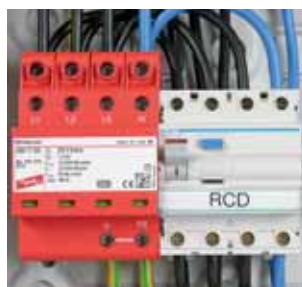
V-образное соединение с клеммой STAK 25, проверенной на токи молнии.
