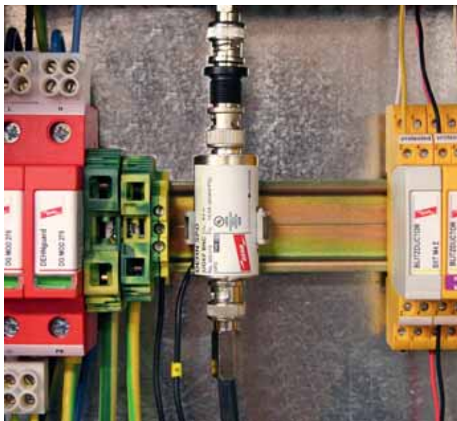
Ограничитель импульсных перенапряжений для применения в качестве кабельного адаптера для коаксиальных систем, например, систем видеонаблюдения.
