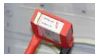
Прямое подключение к сменному модулю DEHNGuard.
