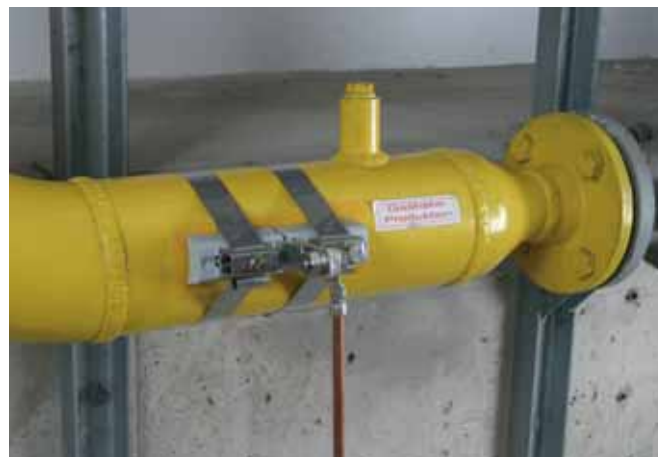
Ленточный хомут для включения труб во взрывоопасных зонах в систему молниезащитного уравнивания потенциалов согласно МЭК 62305-3 (VDE 0185-305-3).
