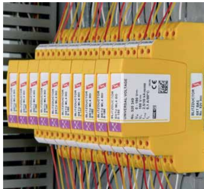
Пример применения BLITZDUCTOR XTU.
