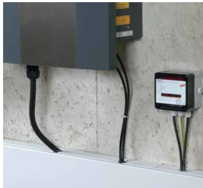
Для защиты низковольтных устройств потребителей от импульсных перенапряжений. Для использования в соответствии с IEC 60364-7-712: (монтаж фотоэлектрических систем электроснабжения).
