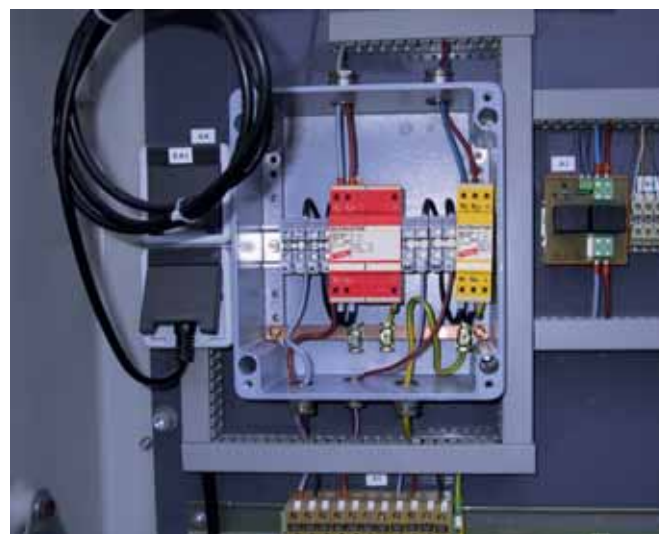
УЗИП для систем активной катодной защиты от коррозии. Со встроенным беспотенциальным переключающим контактом для дистанционного мониторинга состояния (размыкающий контакт).
