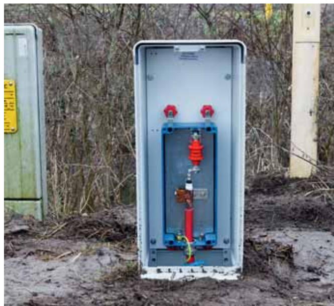
Установочный корпус с искровым разрядником для шунтирования изолирующих фланцев трубопроводов при подземном монтаже и возможностью подключения с помощью коаксиальных кабелей.
