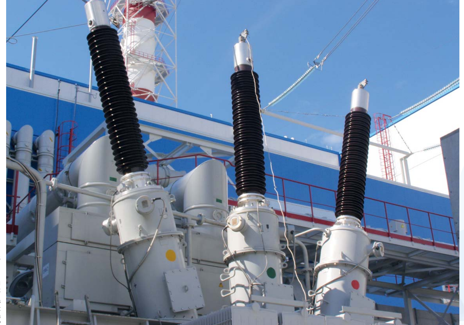
ВТСП ТОУ «СуперОкс» с вводами «Изолятор» на ПС «Мневники» в Москве SuperOx fault current limiter with Izolyator bushings at the SS 'Mnevniki' in Moscow
