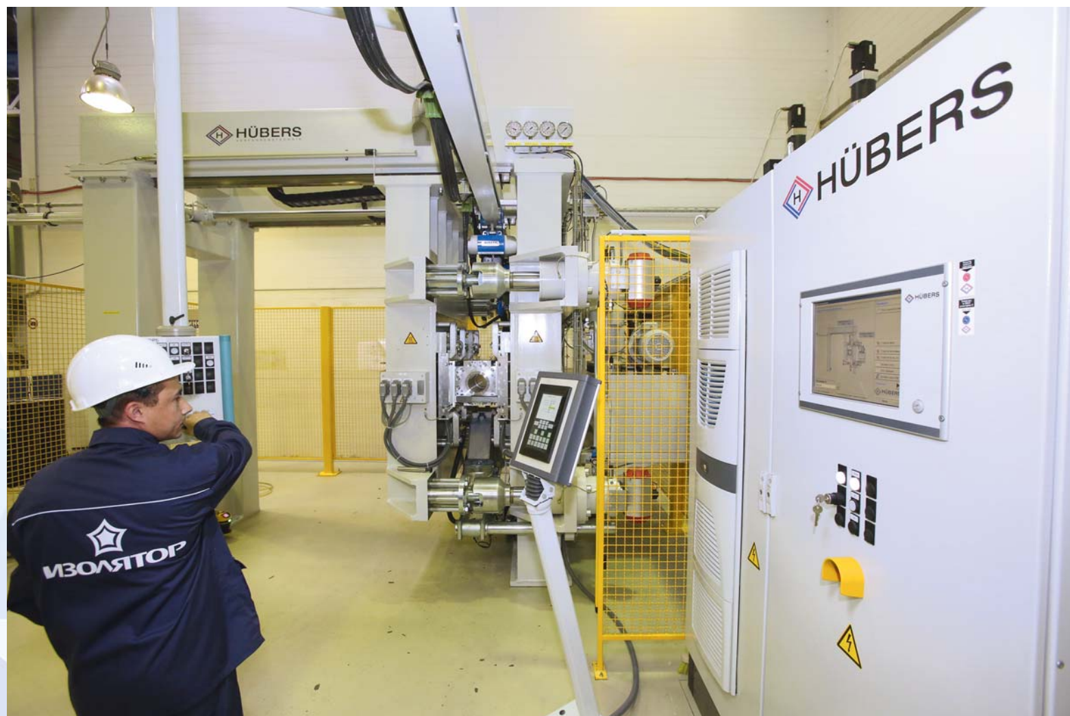
Установка для изготовления силиконовой внешней изоляции Silicone external insulation unit
