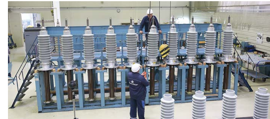
Сборка вводов 126 кВ Assembly of 126 kV bushings
