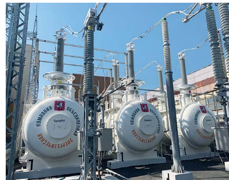
ВТСП ТОУ «СуперОкс» с вводами «Изолятор» на ПС «Мневники» в Москве SuperOx fault current limiter with Izolyator bushings at the SS 'Mnevniki' in Moscow
