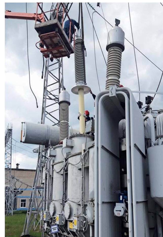
Монтаж ввода 252 кВ с RIN-изоляцией на трансформаторе 40 МВА подстанции 220 кВ «Дальняя» во Владимирской области Installation of 252 kV RIN bushing on a 40 MVA transformer at 220 kV SS Dalnaya in Vladimir region
