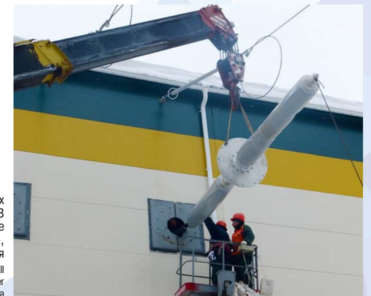
ВТСП ТОУ «СуперОкс» с вводами «Изолятор» на ПС «Мневники» в Москве SuperOx fault current limiter with Izolyator bushings at the SS 'Mnevniki' in Moscow
