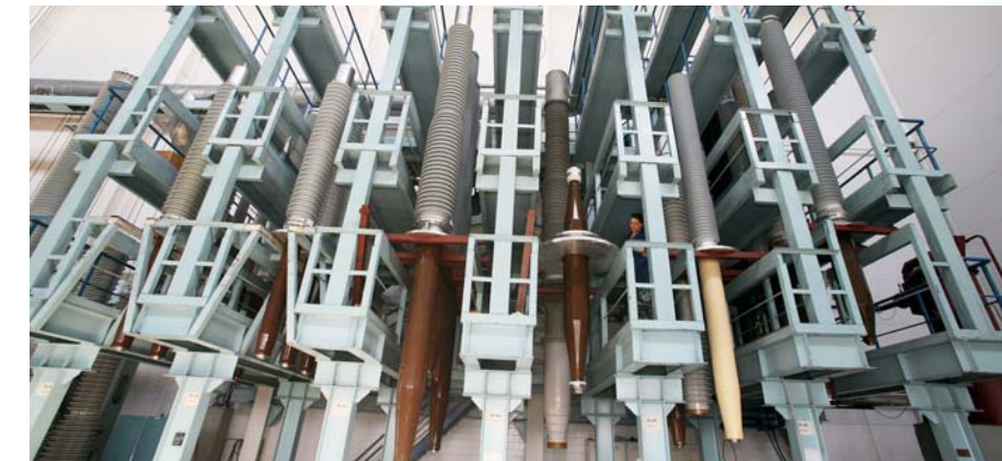
Вводы с RIP- и RIN-изоляцией Bushings with RIP and RIN insulation
