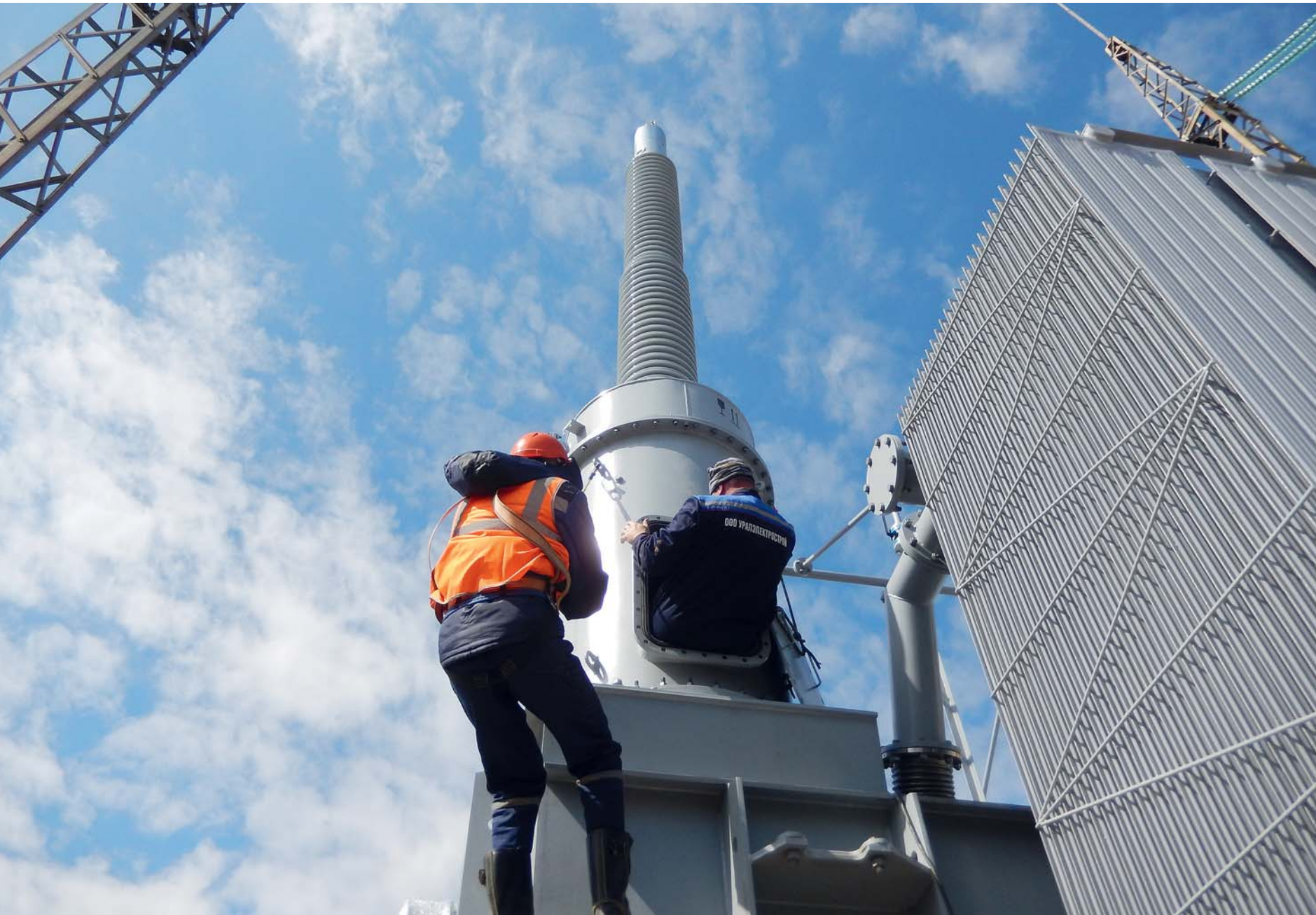
Монтаж ввода 550 кВ на автотрансформаторе МЭС Урала, Россия
