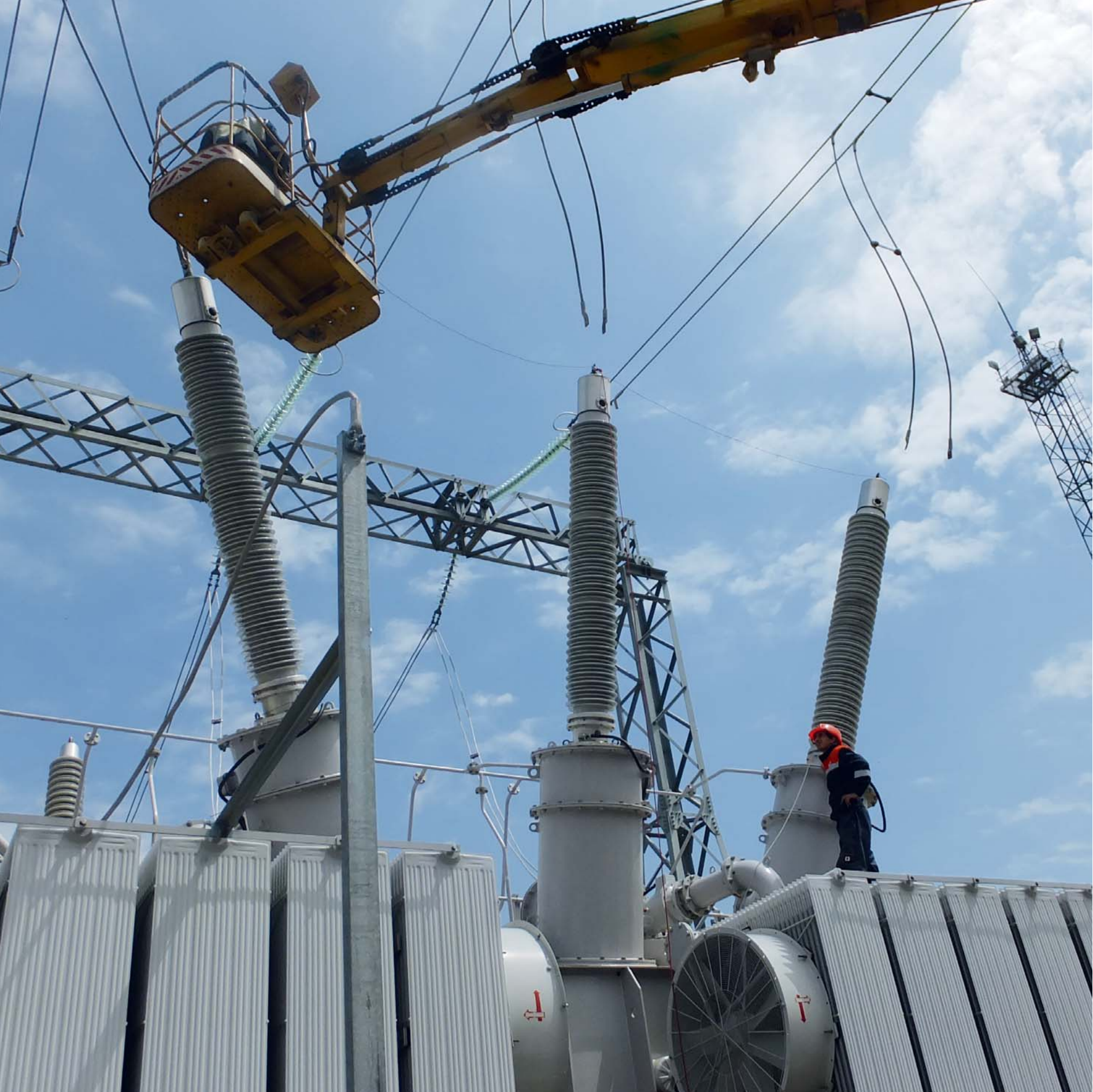
Шеф-монтаж вводов 363 кВ в МЭС Юга Installation supervision of 363 kV bushings at IDGS of South
