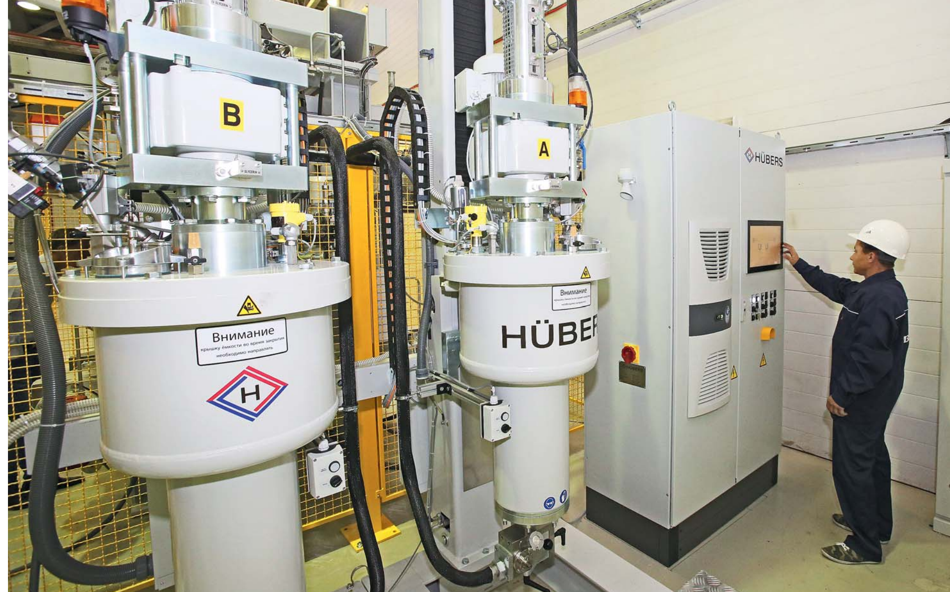
Вакуумно-дегазационное оборудование Vacuum degassing equipment
