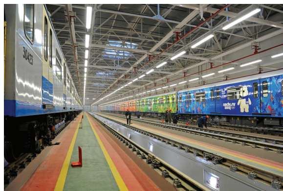
Электродепо Московского метрополитена "Митино"
