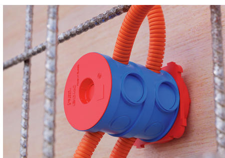
Сборка коробки и укладка бетонной смеси
