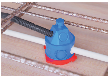
Сборка коробки и укладка бетонной смеси
