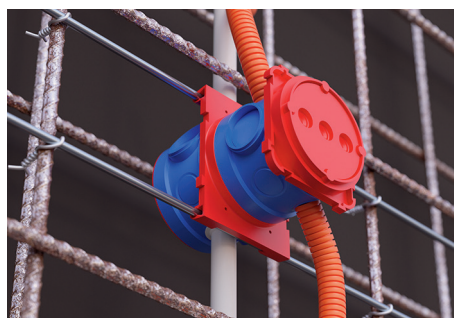
Монтаж коробок к арматурному каркасу
