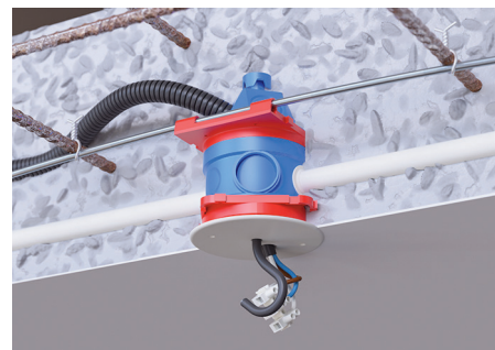
Демонтаж опалубки, протяжка кабеля, установка крюка
