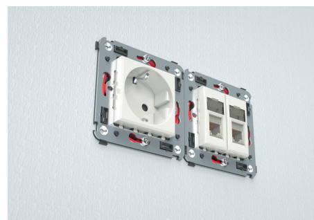
Демонтаж опалубки, протяжка кабеля, установка ЭУ изделий
