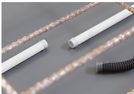
Подведение труб к установочным коробкам
