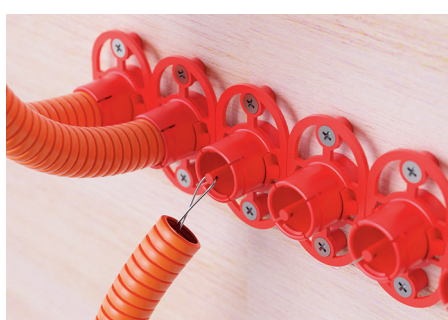
Установка трубы, укладка бетонной смеси
