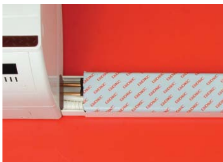
Закройте смонтированную трассу крышкой
