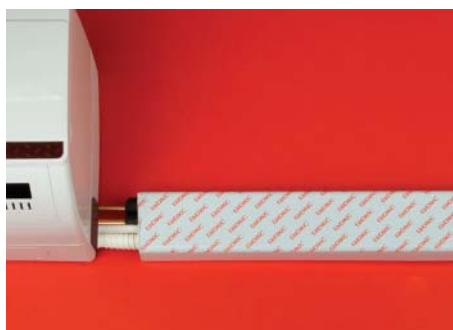
Закройте смонтированную трассу крышкой
