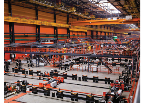
Внутри производственных цехов Опоры внутренних коммуникаций для подключения оборудования
