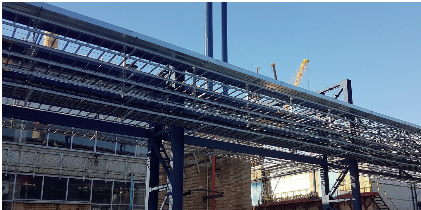
Замена кабельных линий в "Газпромнефть" – МНПЗ (Москва)
