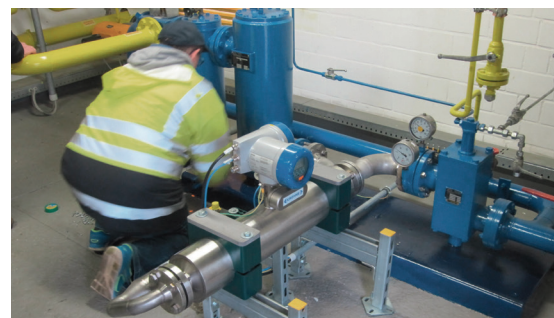
Система для заправки танкеров сжиженным газом, соответствующая требованиям MID MI-005
