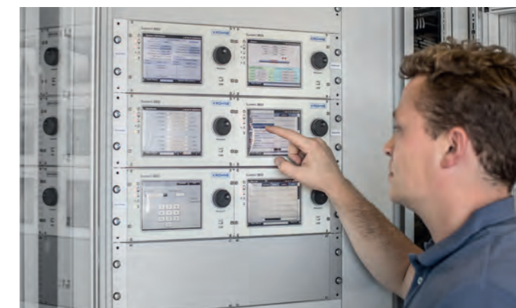
Шкафы диспетчерских систем дистанционного управления на базе вычислителя расхода SUMMIT 8800
