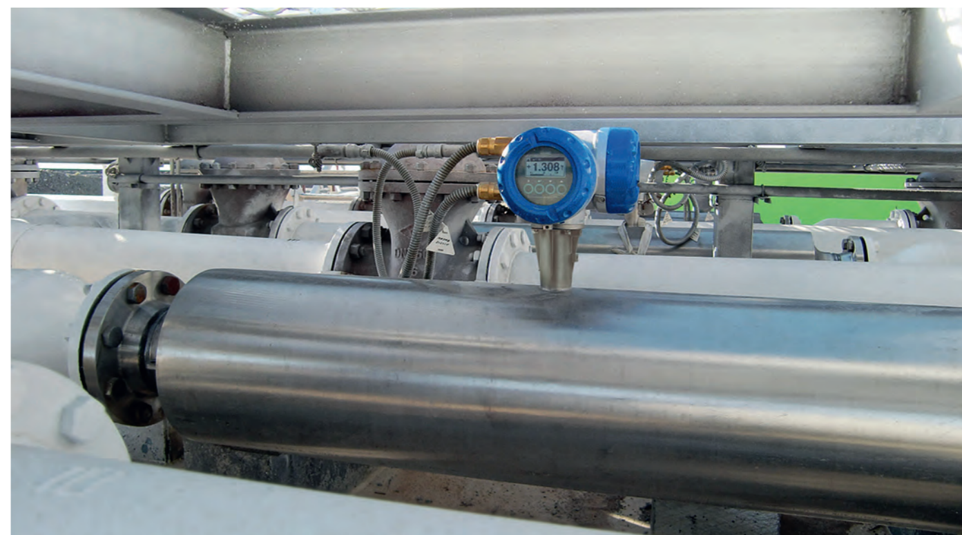
OPTIMASS 2400 — Минимальные размеры монтажа
