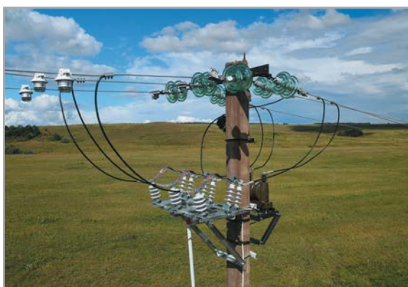
ИКЗ в комплекте интеллектуального разъединителя РИЦ
