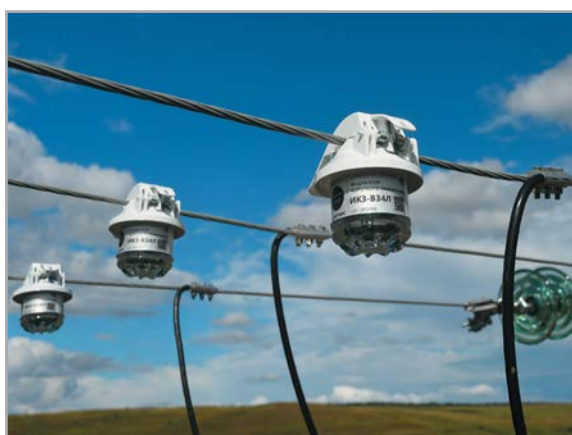
Индикаторы короткого замыкания на проводах
