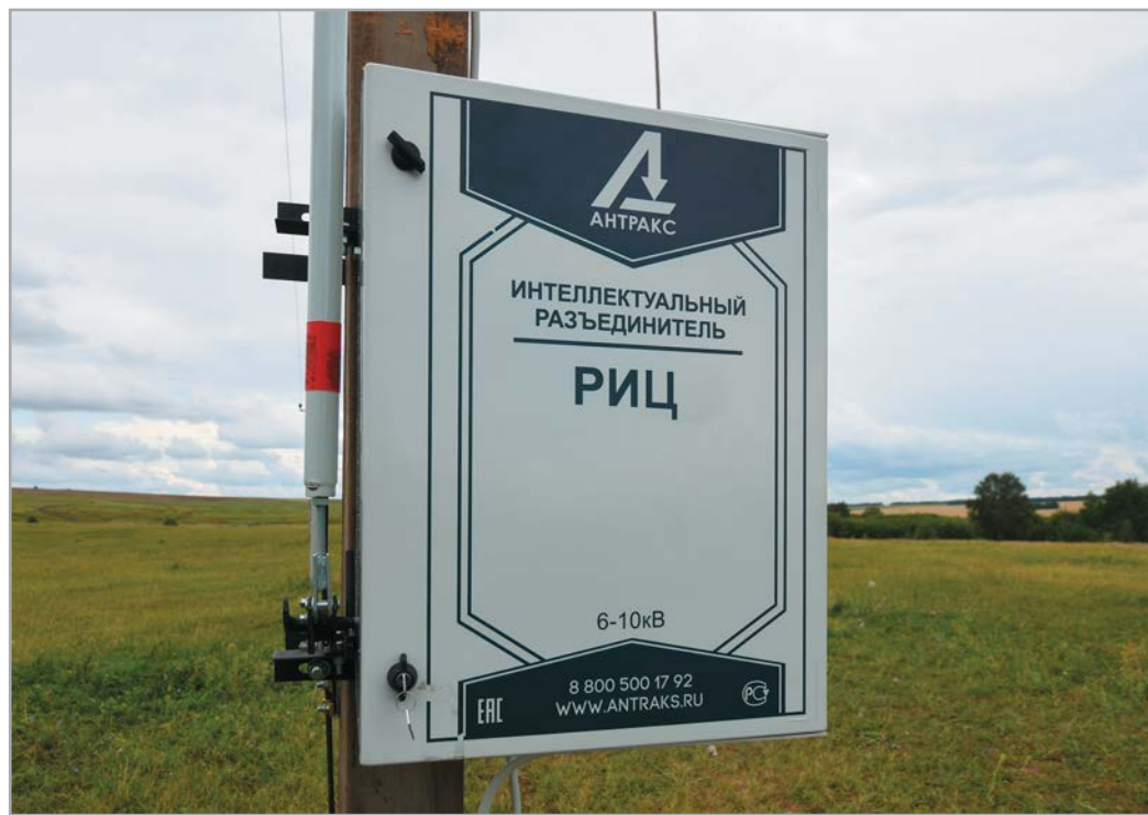
Шкаф управления разъединителем РИЦ
