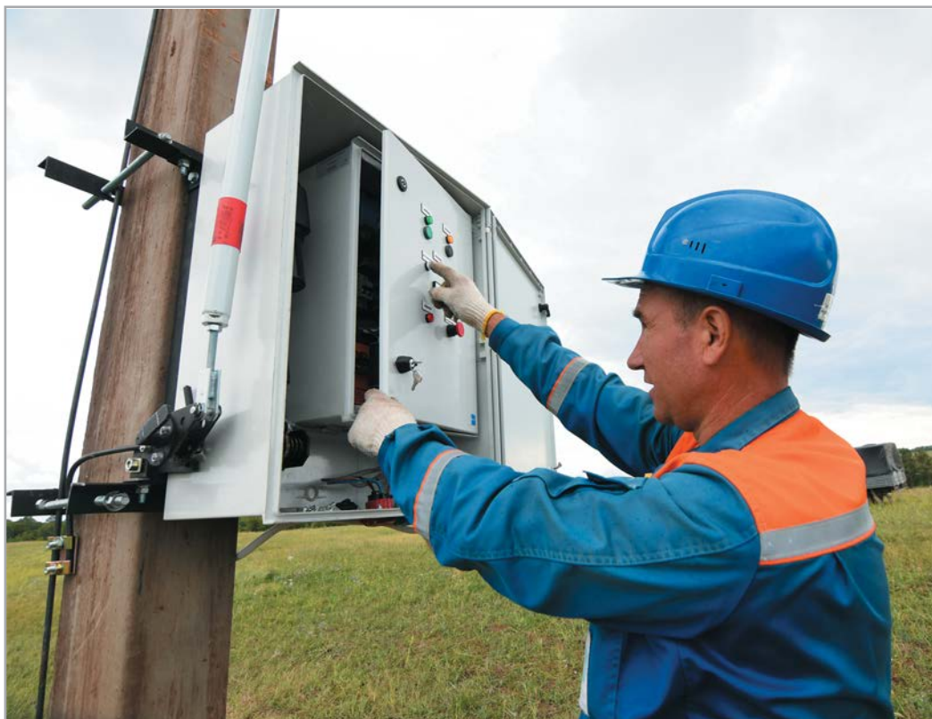
Управление автоматизированным приводом разъединителя в местном и ручном режиме
