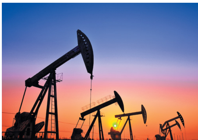
Штанговые глубинные насосы — своеобразный символ нефтедобычи, но большую часть нефти добывают с помощью электрических насосов, установленных в скважине
